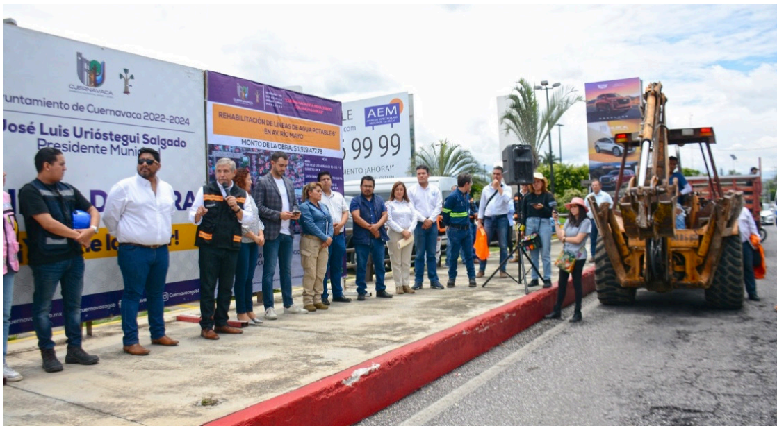
▲ José Luis Urióstegui Salgado, comentó que es fundamental cambiar partes del tramo de red hídrica en la ciudad para evitar la pérdida de agua y hacer que llegue en mayores volúmenes a donde la requieren los habitantes. Foto: Ayuntamiento de Cuernavaca
