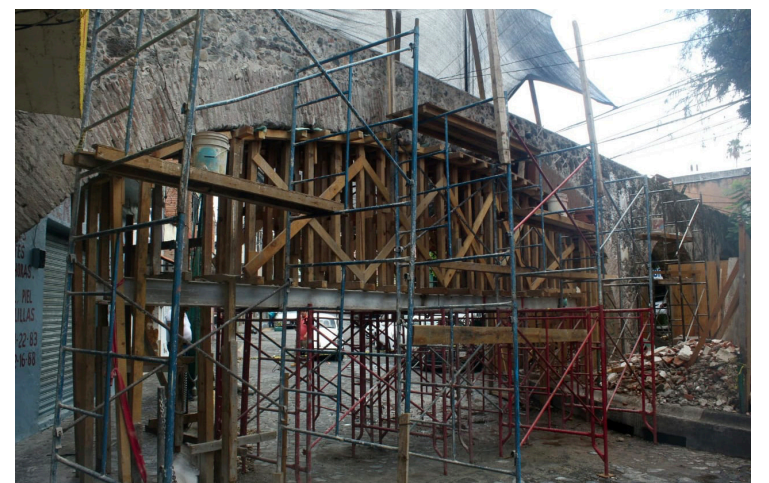
▲ Trabajos de rescate del Acueducto de Gualupita, tras verse afectado por un camión. Foto: Ayuntamiento de Cuernavaca.
